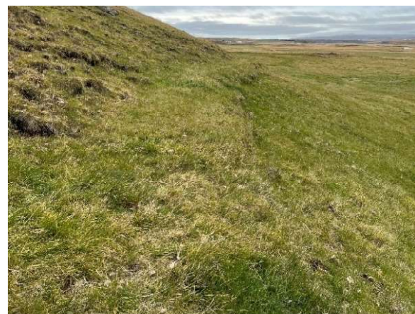
Mynd 9. Túngarður [3316-8], horft til norðurs.
