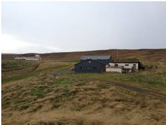
IMG_0423 Horft til vesturs heim að Torfastöðum 1756-8 af Skiphóli.
