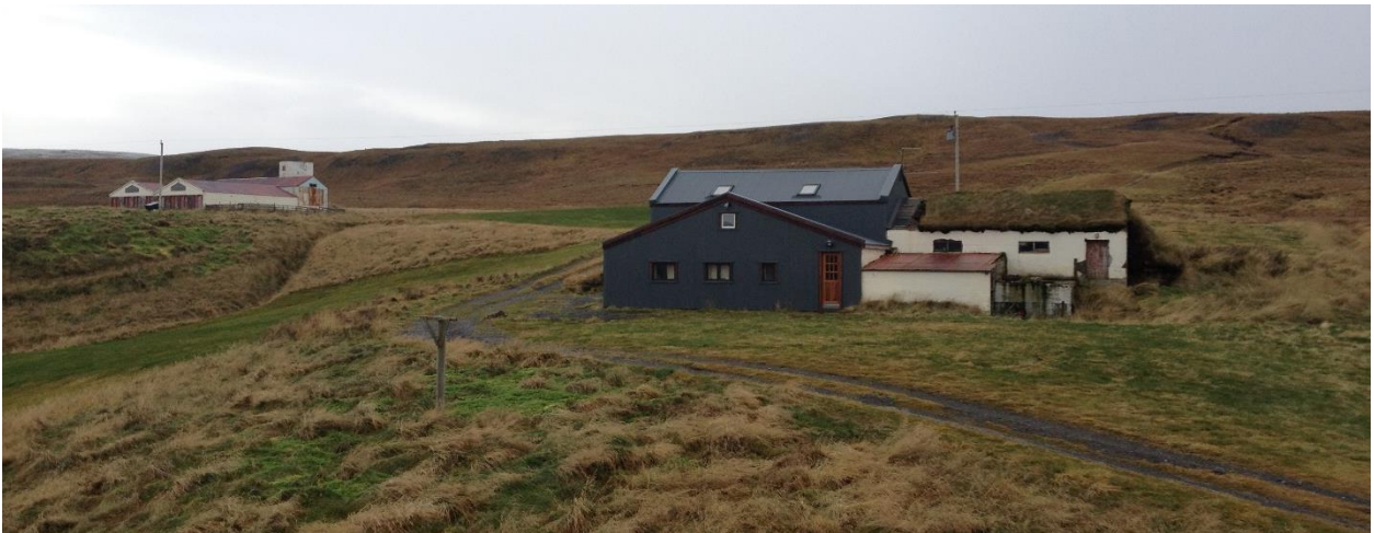
Mynd 6. Horft til vesturs heim að bæ á Torfastöðum.
