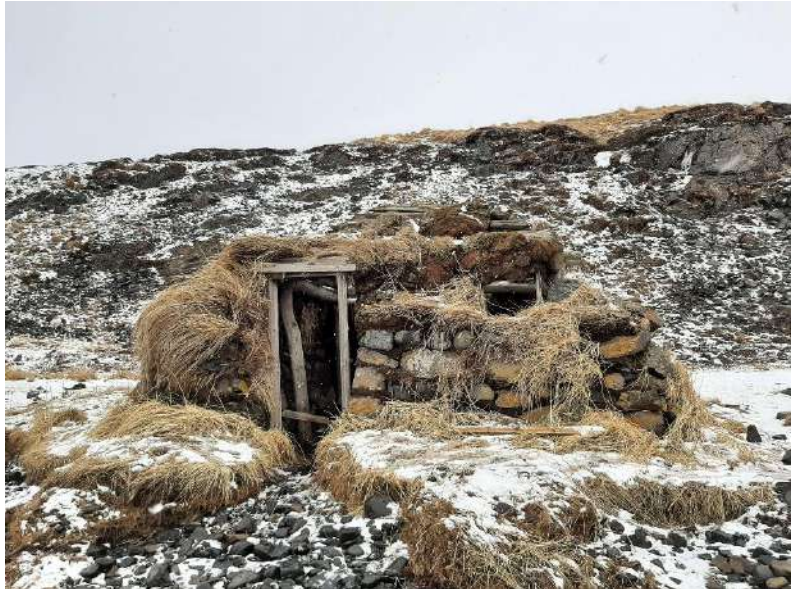
Mynd 19. Ferjumannsskýli Hróbjarts í mars 2022. Skýlið stendur þokkalega en það þyfir að setja nýtt torf efst á vegg og á þak.
