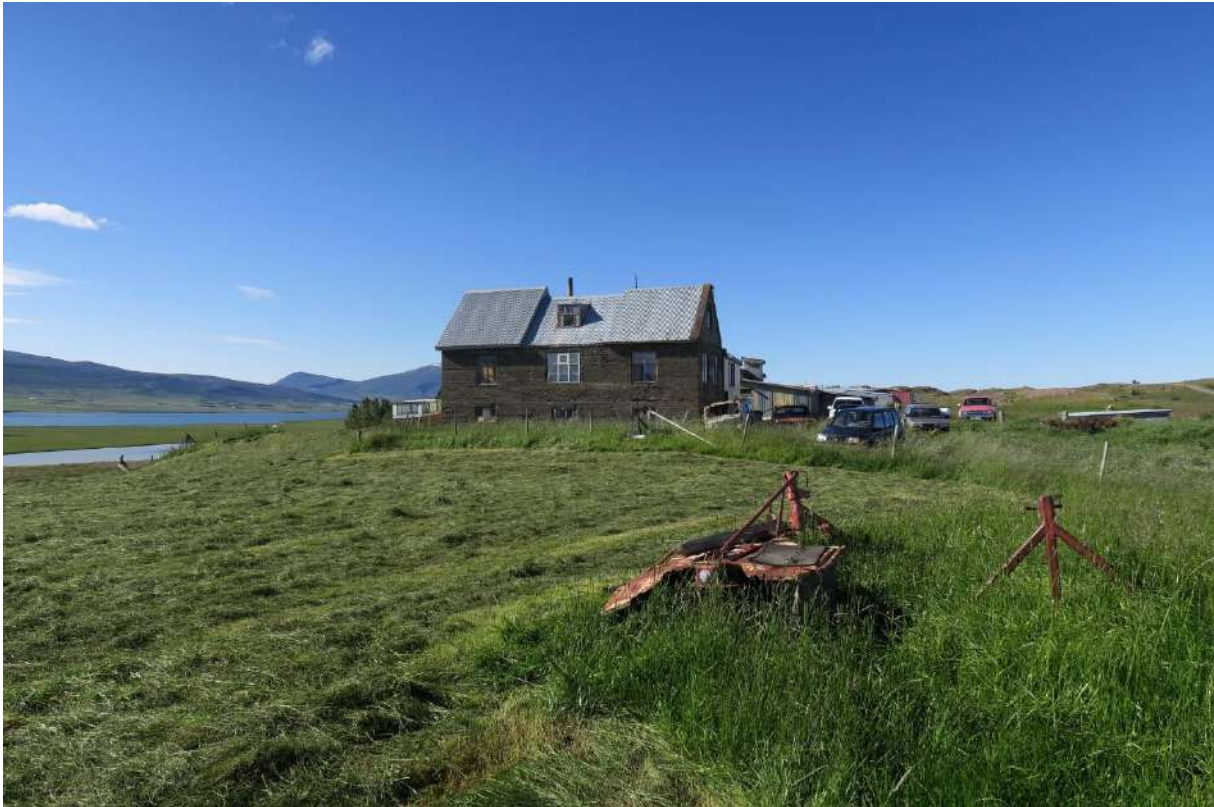
Mynd 94. Gamli bærinn [1728-181] á Kárastöðum stóð þar sem íbúðarhúsið er í dag og var fjós [1728-183] hægra megin við húsið. Horft til norðausturs.
