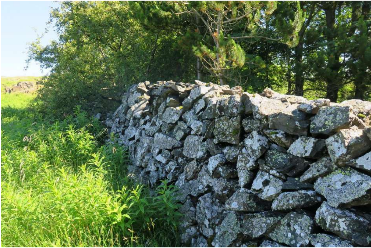
Mynd 101. Grjóthlaðinn garður [1728-198] norðvestan við bæ á Kárastöðum. Horft er til austurs.
