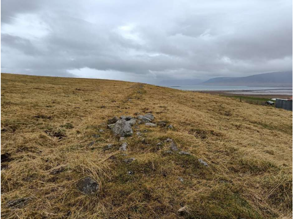
Mynd 345. Horft til norðurs eftir túngarðinum [1728-698] í Garði. Hann hefur að minnsta kosti verið hlaðinn úr grjóti að hluta og er sumt grjótið nokkuð stórt.
