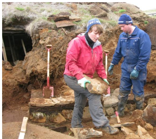
Mynd 9. Grjót valið í vegghleðslu.
