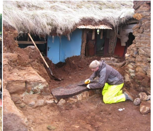
Mynd 8. Strengir skornir saman á neðstu röð grjóthleðslu í suðurvegg búrs.
