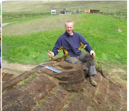
Mynd 12. Torf komið á þak og strompurinn tilbúinn.
